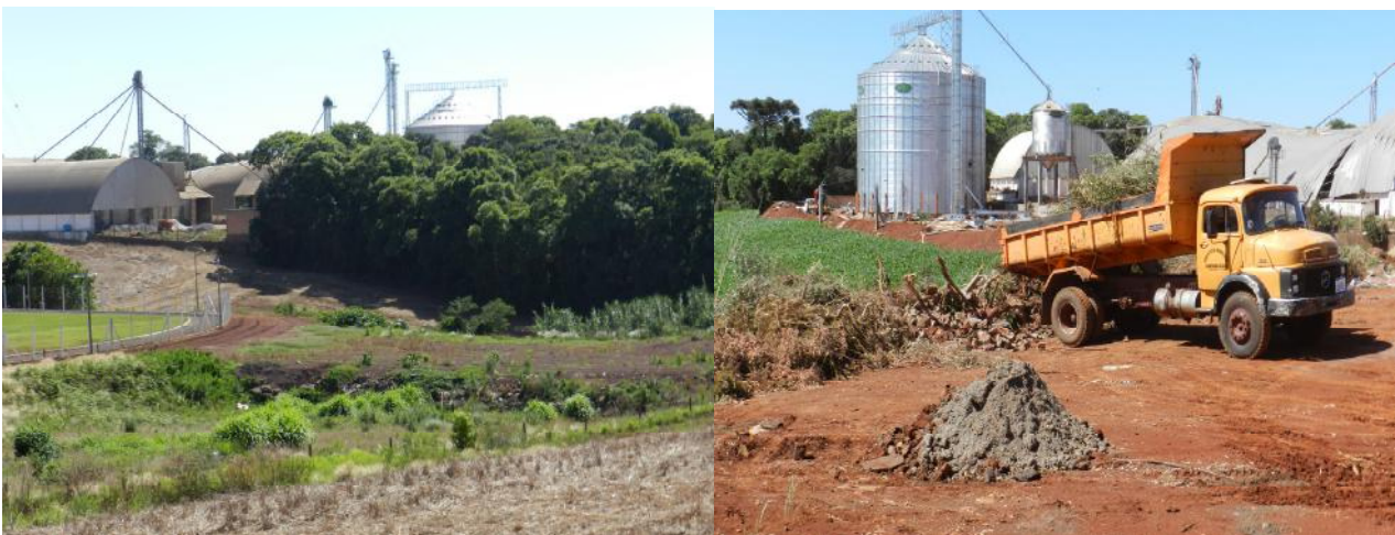
Foto 9. Disposição inadequada de resíduos inertes
