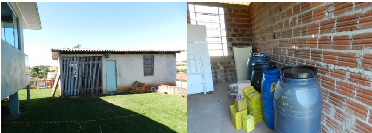
Foto 11. Vista do local de armazenamento dos RSSS
